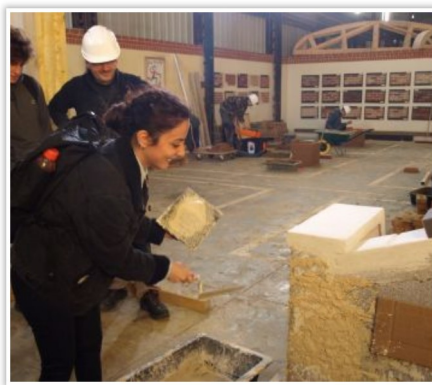
Pendant l'atelier maçonnerie, les étudiants lillois en architecture s'initient à la pose de l'enduit.
