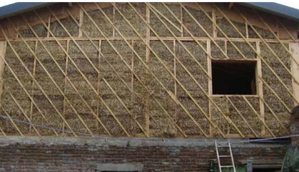
L'ossature en bois verticale, de 22 cm de large, est remplie par des ballots de paille.
