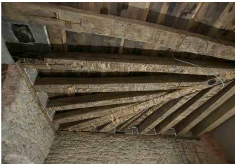
▲ La charpente qui soutient le 2 ème étage est en arête de poisson : une particularité rare.
