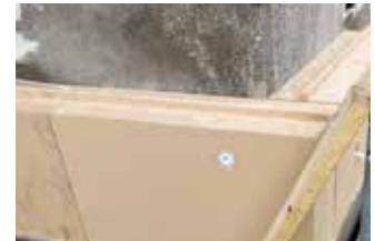
▲ L'isolation extérieure est en fibre de bois de 24cm d'épaisseur.
