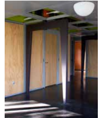
▲ Les faux plafonds n'ont pas été remplacés au-dessus des portiques, afin de mettre en valeur les systèmes constructifs utilisés.
