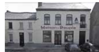
▲ L'ancien café devient une épicerie de proximité. Sol en granito, cheminée de pierre et bar sont d'époque.
