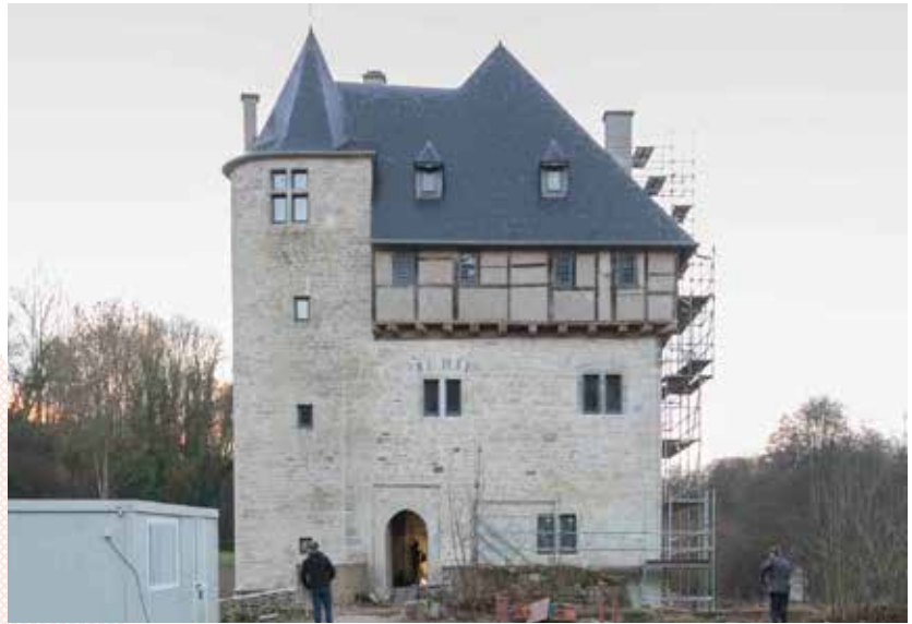
▲ Le donjon de Crupet est en fait une maison forte qui, selon les textes, l'analyse du bâti ou l'étude dendrochronologique des poutres, a été érigée entre 1286 et 1299.
