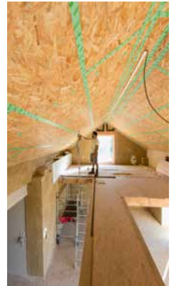
La sous-toiture intérieure est en OSB, étanchéifiée via des raccords spécifiques.
