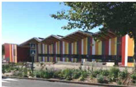
◀ Les anciennes barres de béton ont été transformées en bâtiments colorés, agréables à vivre et à regarder.
