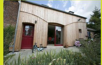
12.00 **Colleret (FR)**: Visite du chantier d'une maison individuelle, c'est une extension neuve de 70m<sup>2</sup> en ossature bois; une isolation paille est faite par l'extérieur; des enduits de terre seront placés en intérieur et aussi extérieur. Ce chantier est suivi par des artisans accompagnateurs: Vincent Lalande (charpente et paille) et Charles Cintré, Lucie Dautreppe (paille et enduits terre) le 6 octobre pour notre visite, la charpente devrait être terminée.
